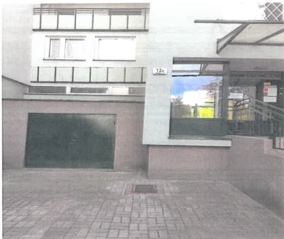
TRAFOSTACJA ZWM 12A
